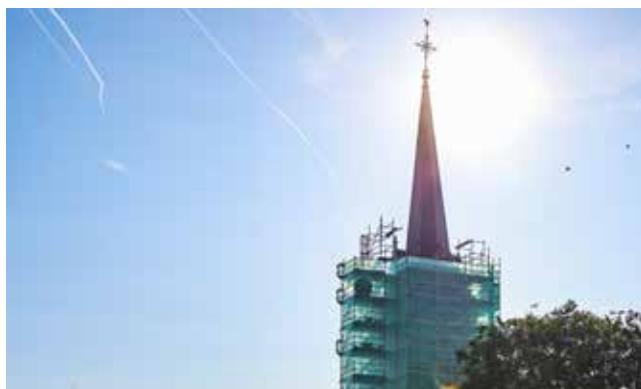
Nach dem Aufbau der Gerüste wurden die Werksteine an den vier Seiten im oberen Bereich des Kirchturms sowie das gesamte Maßwerk, insbesondere im Bereich der Schallöffnungen auf Höhe des Glockenstuhls detailliert begutachtet und die Schäden in sogenannte Kartierungspläne eingetragen. Diese Kartierung wird laufend fortgeschrieben, da manche Schäden erst während der Arbeiten - nach Ausbau von Werksteinen - sichtbar werden.
